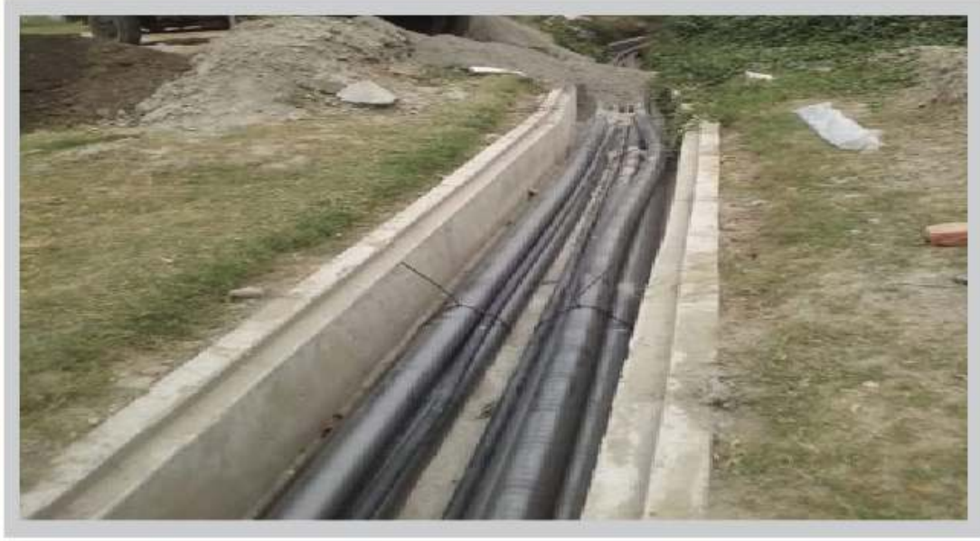
চর সৈয়দপুর ১৩২/৩৩ কেভি গ্রীড উপকেন্দ্র ভূগর্ভস্থ সোর্স লাইনের কাজ।
